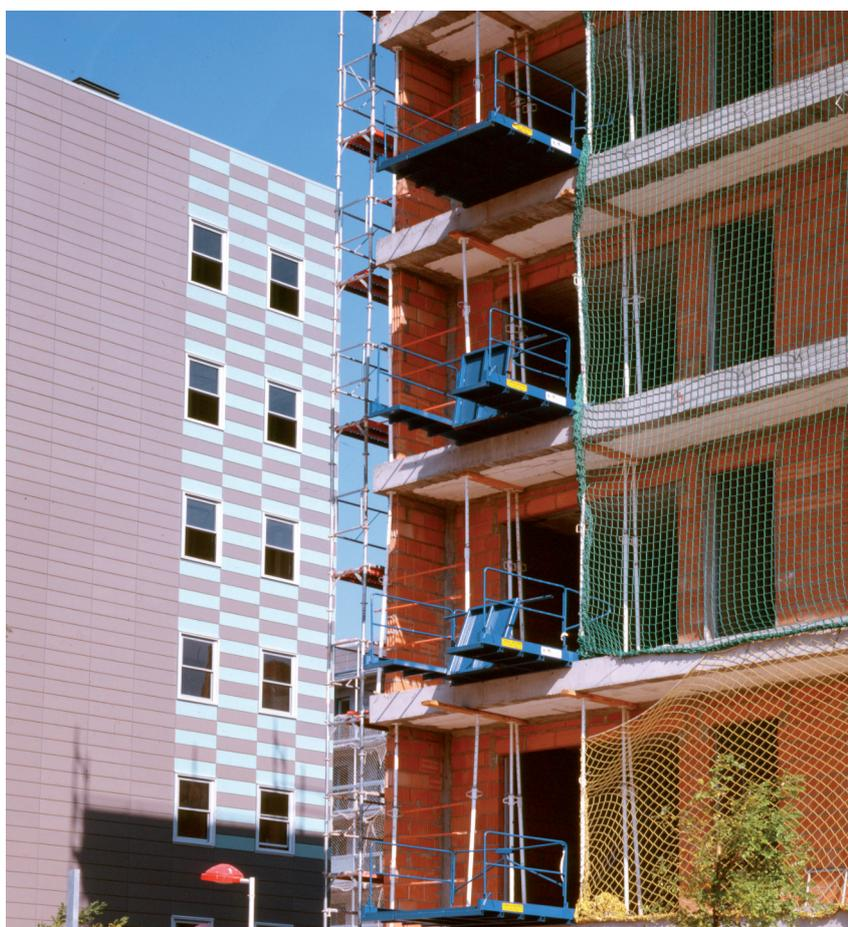
Plataformas metálicas para la recepción de materiales en planta, que facilitan la labor de los operarios en la obra, evitando esfuerzos innecesarios y minimizando el riesgo de accidentes, gracias a la configuración de las barandillas y a las puertas de seguridad abatibles.
