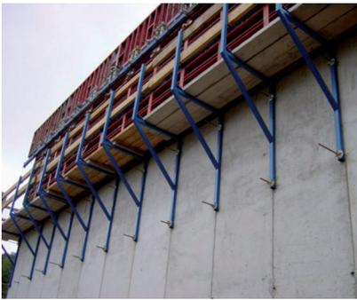
Aprovechando el muro que hemos hormigonado sujetaremos haciendo coincidir los pasos de varillas diwidag existentes sobre las cuales apoyaremos los paneles para el siguiente hormigonado. Dichas ménsulas también sirven para soportar los puntales de nivelación y como apoyo para las plataformas de trabajo para los operarios.
