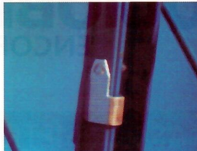
Detalle de la unión entre Tabicas mediante Cangrejo de 0.20.
